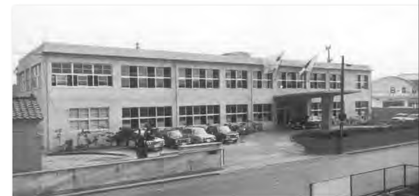
昭和43年 旧柏崎市庁舎を取得改装した当社本館
